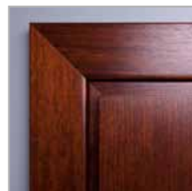
spojování lišt pod úhlem 45°
