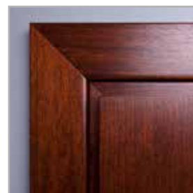
spojování lišt pod úhlem 45°
