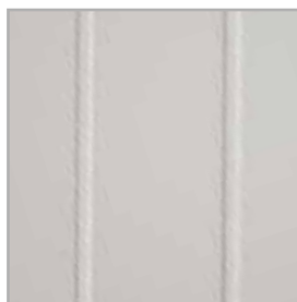
frézování na povrchu křídla
