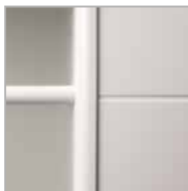
pohled na frézování
